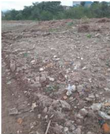
Figura 4 - Descarte de RCC na margem do córrego Fronteiriço
